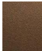
Rost 1 Rostiges Eisen
