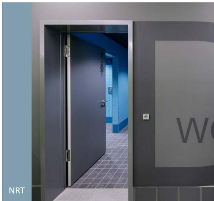
Wo Materialien wie Stahl oder Holz an Grenzen stoßen, zeigen Nassraumtüren mit Aluminiumzargen ihre Stärke. In Schwimmbädern, Wellnessbereichen oder Sanitärräumen sind Türen und Zargen dauerhaft Feuchtigkeit, Nässe und Reinigungsmitteln ausgesetzt – hier entfaltet der Werkstoff Aluminium seine Vorteile: kein Rost, kein Aufquellen, keine Fäulnis, stattdessen Korrosionsbeständigkeit, Belastbarkeit und zeitlose Eleganz.
