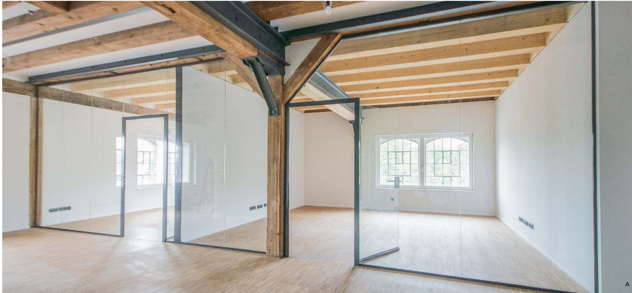
A - D | Verglasungen mit umlaufendem U-Profil oder Blockzarge BF30 und Zarge KLF30-35 mit Ganzglastüren
