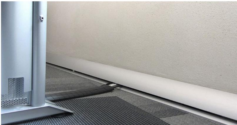
Kanal in den Boden eingelassen, lediglich der Deckel steht noch über den Bodenbelag
