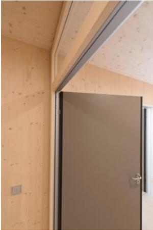
(BU): Fingerschutzzarge HFI in Kombination mit Holzstock und Verglasung, Türblatt mit Knautschzone an der Nebenschließkante (Detail).
