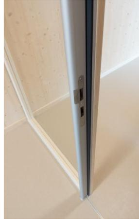
(BU): Fingerschutzzarge HFI in Verbindung mit Verglasung und Holzstock, mit ER-Schließblech und Fallenführung (Detail).
