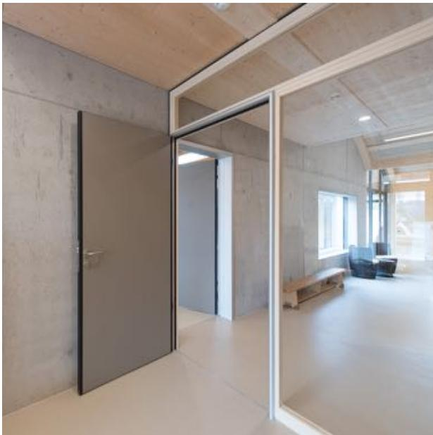
(BU): Festverglasung als Holzelement mit Fingerschutz – Minimierung der Verletzungsgefahr durch nachgiebige Bereiche der Haupt- und Nebenschließkante.
