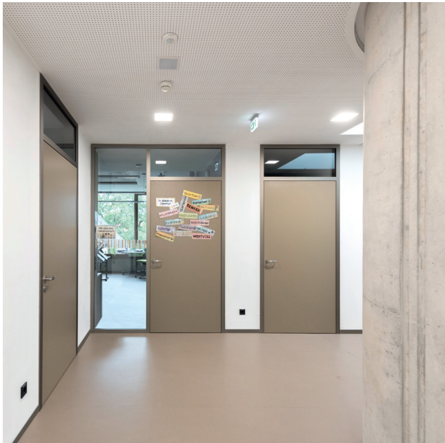
BU 3: Bandgegenseitig flächenbündig: Das Profil kann auch verwendet werden für Verglasungen mit einfachen 10 mm ESG-oder VSG-Scheiben.
