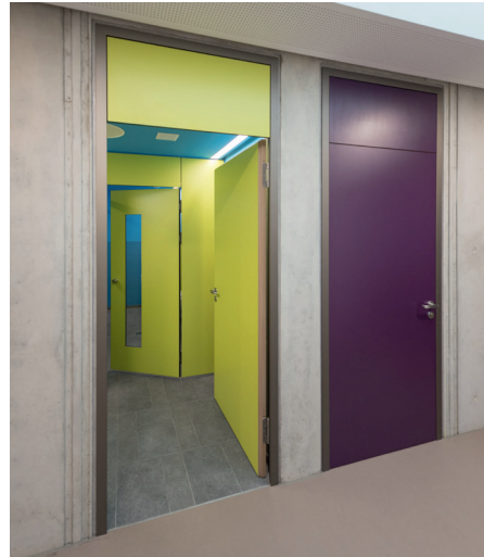
BU 2: Die Konstruktion der neuen TLS Blockzarge ermöglicht mit geringen Mitteln eine band- gegenseitige nahezu flächenbündige Optik.
