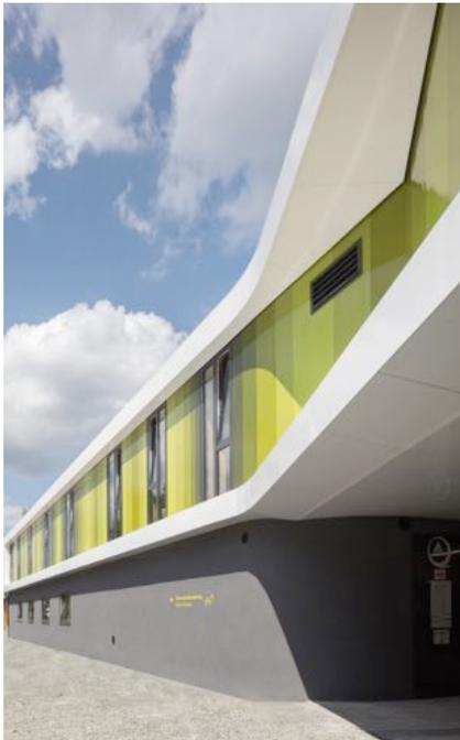
(BU) Die Küffner Aluminiumpaneele mit geschlossener Oberfläche können neben Fassaden auch für Dachuntersichten, Wand- und Unterdeckenverkleidungen eingesetzt werden.
