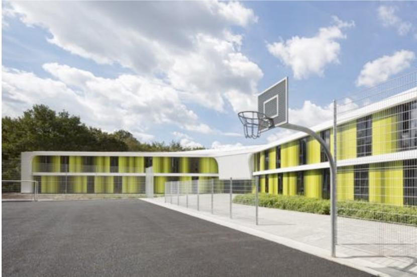
(BU) In fünf pulverlackierten, abgestuften Gelb- und Grüntönen halten die 100 mm breiten Aluminiumprofile der Witterung nachhaltig stand.
