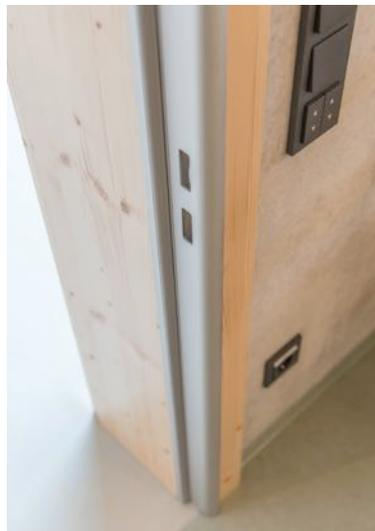
(BU): Barrierefrei zertifizierter Fingerschutz ohne nachträgliche Abdeckungen oder Rollos. Durch ein geringstmögliches Spaltmaß, verdeckt liegendes massives Bandsystem und Knautschzonen an Haupt- und Nebenschließkanten ist für die erforderliche Sicherheit von Kinderfingern gesorgt.
