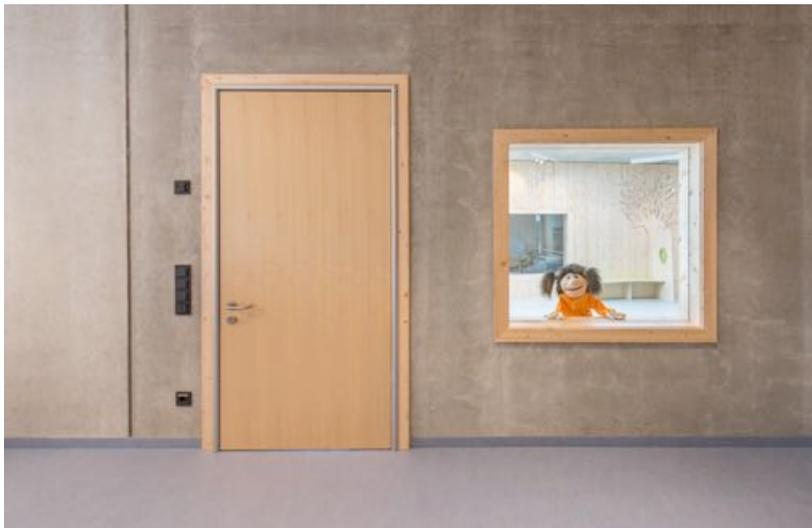
Nachhaltiges Holz-Design im Fokus: Die mit Fichte furnierten Küffner Fingerschutztüren fügen sich harmonisch in die Architektur des Kinderdorfes ein. Die eloxierten Aluminiumprofile der Zarge korrespondieren dabei mit den Sichtbetonwänden.
