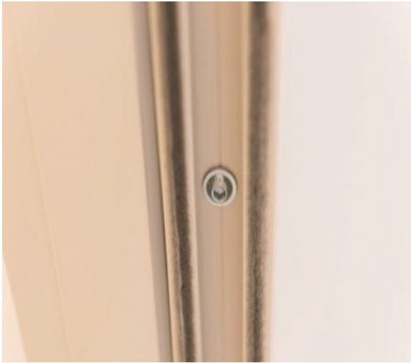
Foto 11 (BU): Bürstendichtung mit zusätzlicher Foliendichtung für den wirksamen Schallschutz der Raumspartür an der oberen Türblattkante.
