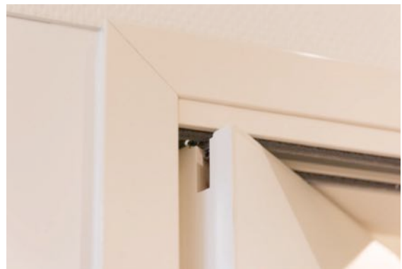
Foto 12 (BU): Oberes Ecklager des Türblattes in der Führungsschiene der Raumspartür, die selbst nachträglich in den Zargenfalz jeder Standardzarge montiert werden kann
