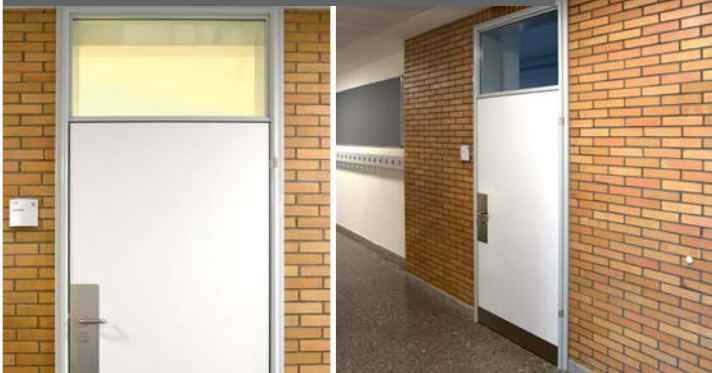
OBJEKT | Alois Schreiber Schule, Bühl | Renovierungszarge RENOFI
