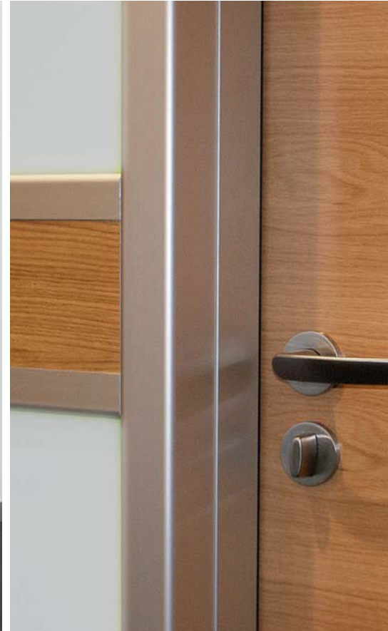
Anschlußdetail Wandrammschutz WRA
