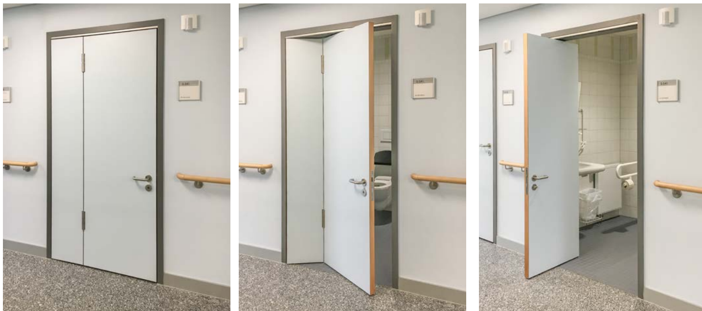
Barrierefreie Toilette im öffentlichen Gebäude – komfortable Nutzbarkeit für Menschen mit Rollstuhl und Rollator, durch geringen Schwenkradius und Erreichbarkeit der Türklinke.
