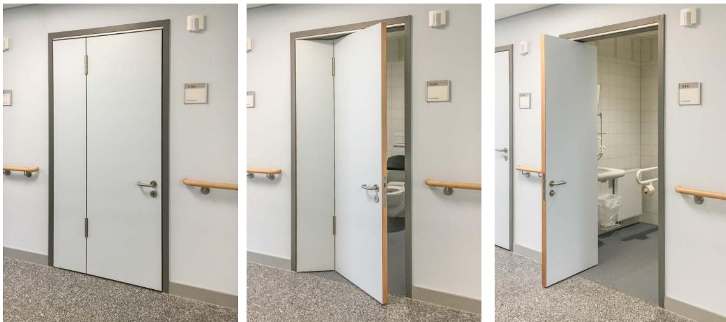
Barrierefreie Toilette im öffentlichen Gebäude – komfortable Nutzbarkeit für Menschen mit Rollstuhl und Rollator, durch geringen Schwenkradius und Erreichbarkeit der Türklinke. Objekt: Oberlausitz-Kliniken - Krankenhaus Bautzen
