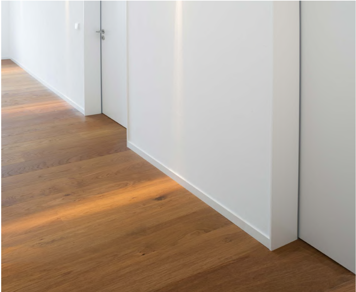
■ Sockelprofil G60-8 montiert an 10mm vorstehende Aluminium-Laibungszarge Typ FZS48-5-42S
